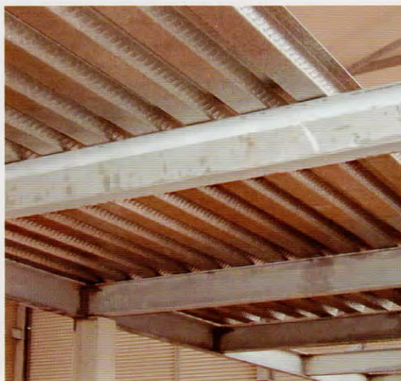
Colocação do Perfil COLABORANTE PC65
