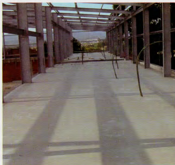
Vista da laje depois de betonada.
