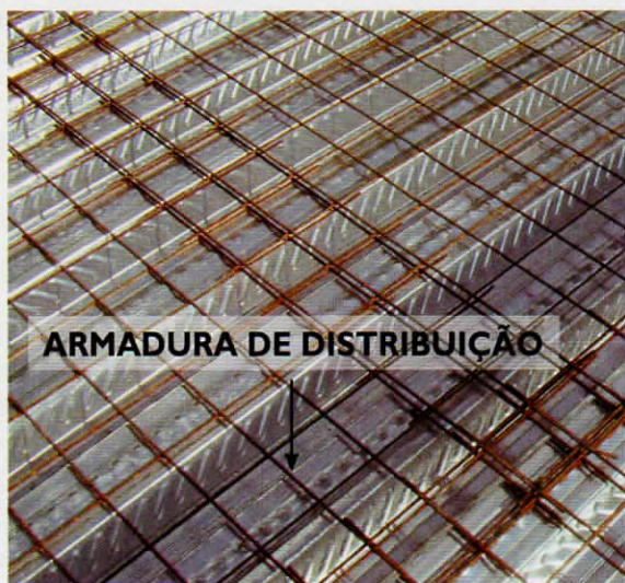
Colocação da Armadura de Distribuição
